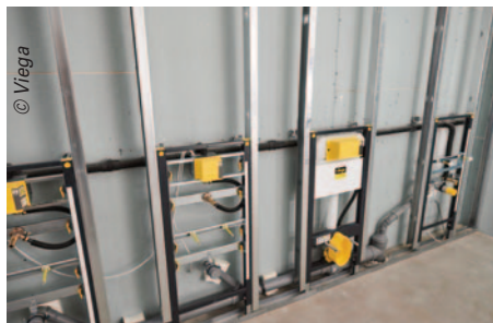
Le bâti support Prevista de Viega offre également la possibilité d'installer une cuvette lavante, quel que soit le fabricant, via un kit de raccordement disponible en option.
