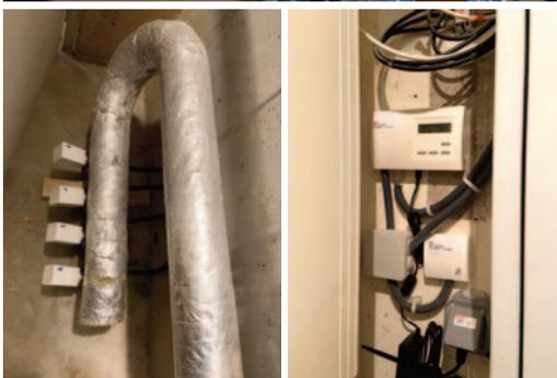
avec une unité centrale de régulation ZE installée en local technique. Grâce à son algorithme breveté, la ZE pilote en fonction des besoins effectifs des appartements les moteurs de vanne SK sur les collecteurs du plancher chauffant pour gérer l'apport énergétique au plus juste.
