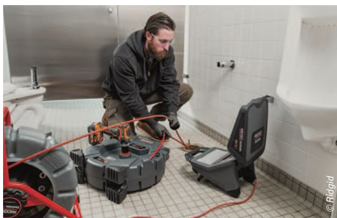
FlexShaft de Ridgid (ici présenté en parallèle d'une caméra d'inspection) permet de déboucher les conduits par action mécanique.
